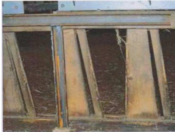
Un système de T rigidifiant à l'intersection des deux longueurs de cornadis est plus efficace qu'un fer en U ou une cornière seule. En effet, ces parties sont plus fragiles. Bien vérifier que les boulons de la fixation du T ne gênent pas l'ouverture et la fermeture du cornadis.
