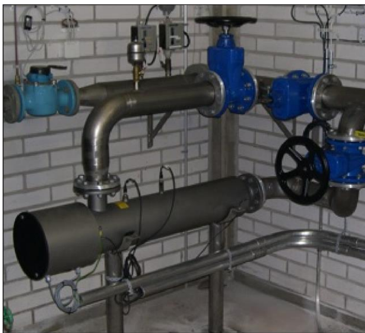
Système UV type BétaLine équipé d'un mécanisme de nettoyage automatique
